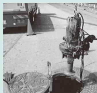
マンホールポンプの 引き上げ作業の様子
